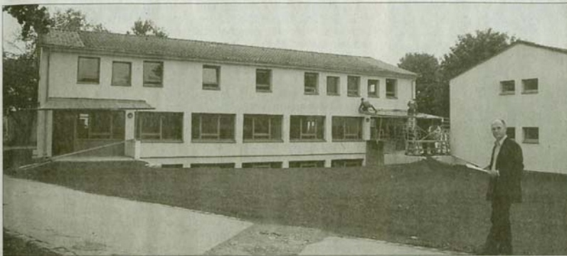
Vier sanierungsbedürftige ehemalige Gruppenräume hat Mutpol zu Schulgebäuden für die gut 180 Schüler in der Stammschule umbauen lassen, zeigt Gesamtleiter Dieter Kießling.
