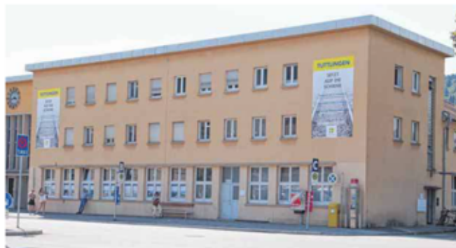
In der alten Lokführer-Unterkunft im östlichen Teil des Bahnhofes kommen bald sechs jugendliche unbegleitete Flüchtlinge unter. FOTO: CG
